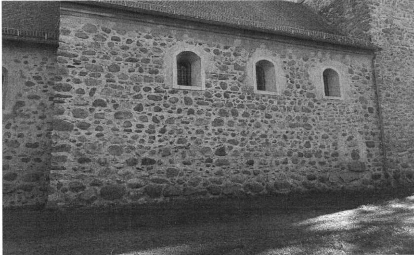
*Nordseite des Kirchenschiffes. Erkennbar ist das bis 0,90 m über Geländehöhe freigelegte, stark vorstehende Fundamentmauerwerk. Bis auf Strukturstörungen im Bereich der westlichen Fensterachse ist ein regelmäßiges Mauerwerk aus sortierten Findlingen sichtbar.*
