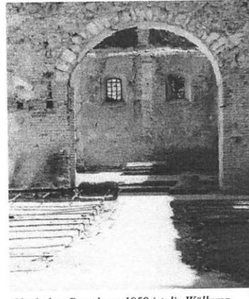
*Nach dem Brand von 1959 ist die Wölbung des Triumphbogens aus behauenen Steinen sichtbar. Dahinter: Blick auf die Chorwand mit den Resten der im Jahr 1898 angebauten Esse.*
