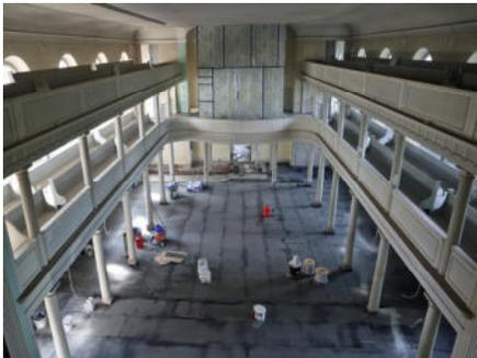
Auch die Bauarbeiten an der **Gedächtniskirche in Schönefeld** gehen voran. Heute wurden gerade die verschiedenen Steckdosen im Fußboden der Kirche besprochen. Dieser Schritt ist so sensibel, weil wir einen Gussasphalt einbringen wollen, der ähnlich dem Terrazzo im Vorraum, der Gedächtnishalle, aussieht. Da kann man anders als bei Steckdosen in den Wänden später nicht leicht korrigieren. Die beiden Bankblöcke mit Mittelgang werden dann auf einer Fußbodenheizung stehen.
